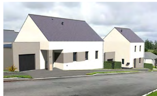
Construction en cours au Ferré
