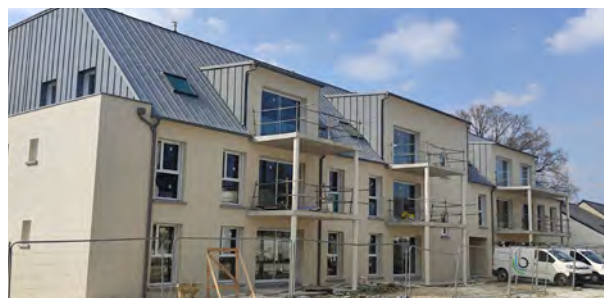
Construction en cours à Fougères – Résidence Quai 25
